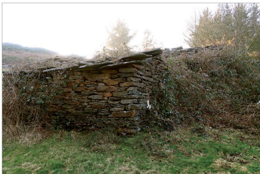
1. Vista desde el sur, donde se aprecia el hundimiento parcial de la cubierta. A la derecha, en avance sobre la fachada este, vemos el arranque del muro que cerraba la *corrada*.
