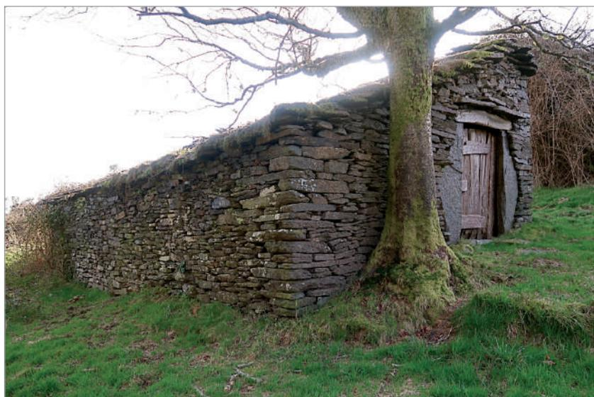
1. Fachada norte, con la puerta de acceso a la *corte de Casa Cobo*. Ésta presenta solución de *banzos* y tiene, como es común en la braña, *cargadeiro* (dintel) de madera, con el típico *veiro* de losas en la parte superior para preservarlo del arroyo del agua. La cimera del muro de cerramiento del lado oeste se remata en chaflán, permitiendo que las *llouxas* de cobertera viertan en ese punto en sentido opuesto (como en una cubierta a dos aguas) y favoreciendo el rápido desalajo del agua.
