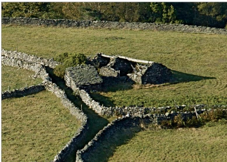
1. Vista posterior de la *cabana* donde podemos apreciar cómo la altura de muros va disminuyendo a partir de la entrada, pasando de 2,25 m en el punto más elevado, a 1,25 m en el muro trasero. Por el lateral, cerrado con una *cancell*, discurre uno de los caminos interiores de la braña.
