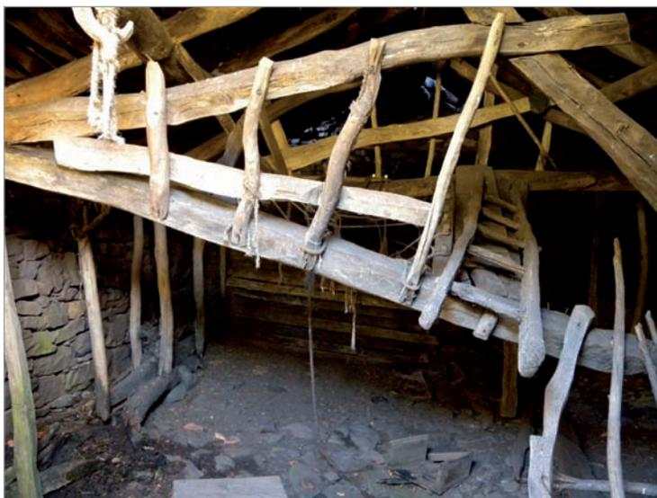
1. Vista de conjunto de la cabaña donde podemos apreciar los materiales de cubierta: teja del país colocada en seco y reforzada con piedras, y *l.lábanas* o lajas pétreas en los aleros. Al fondo, el *corro* C-01.
