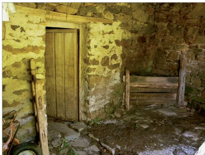
1. Una vista de la *cabana* del vaquero cuyo exterior muestra que fue objeto de una amplia renovación: el encuentro de las aguas de la cubierta se resuelve con una hilera de tejas de fábrica; se rejunteó la mampostería, se intervino en los huecos y se introdujo la cocina con chimenea. A la derecha de la imagen, la *portiel.la* de acceso a un amplio prado de siega vinculado a la cabaña.
