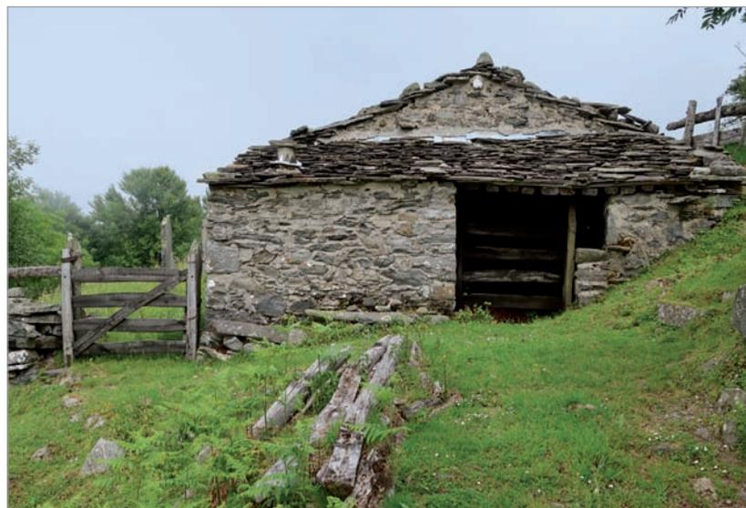
1. Vista posterior con la puerta de acceso al *esteblu*. Éste dispone de dos puertas enfrentadas: una desde el exterior y otra desde el *portal*. La construcción fue ampliamente renovada: rejunteado generalizado de la mampostería, introducción de elementos de impermeabilización en la cubierta, introducción de chimenea...
