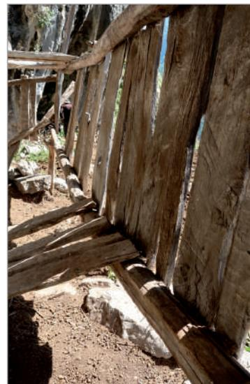
1. Vista general del *veru* desde el lado este, ya parcialmente desmantelado. Los postes esquineros que sirven de soporte a la estructura conservan el nacimiento de algunas ramas en forma de horquilla, donde se apoyan los rollizos horizontales que conforman la «caja» del *veru*. Uno de dichos postes se alarga hasta superar los 3 m, rematando en unos *gayos* que servían de colgadero: se trata de un *arrudu*, donde dejaban al sereno los *vexigos* (odres) con la *llechi mecíu* (leche ordeñada).
