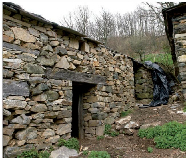
1. Vista de conjunto de la *cabana* de Casa Cueto donde se aprecia el asentamiento contra el *turrio* (talud) y su volumen parcialmente excavado en la ladera. Destaca también la estructura mixta de los muros, con vigas de roble intercaladas de considerable sección, que quizá debido a la escasa trabazón de las esquinas no sirvieron para garantizar la solidez de la estructura.
