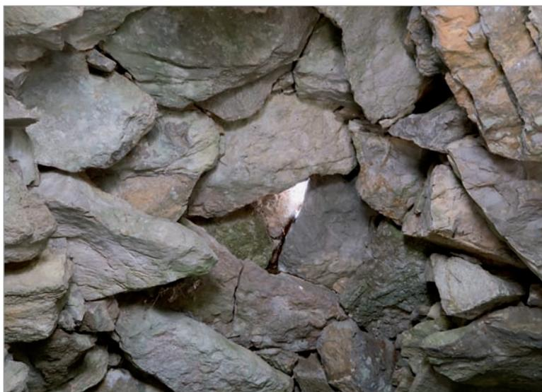
1. Vista posterior del *vellar* donde podemos apreciar la capa exterior de *tapinos* (césped) que contribuye a la estanqueidad de la cubierta. Su perímetro alcanza los 11,40 m.
