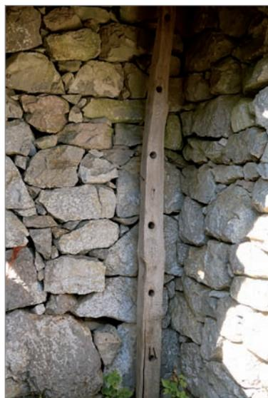
1-2. Vistas laterales y posterior del *cabañu* con muros de mampostería de piedra caliza colocada en seco.
