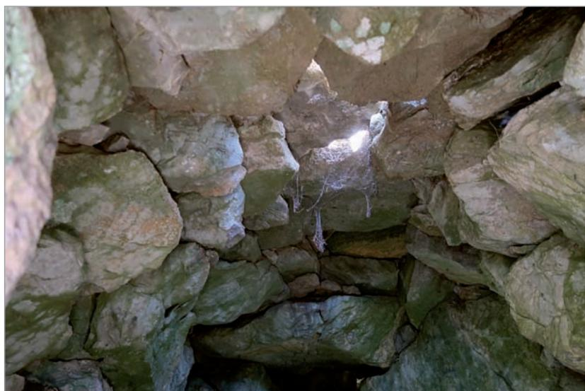
1. Vista posterior del *vellar* construido en mampostería, con toscos bloques de caliza colocados en seco. La falsa bóveda se recubre exteriormente con *tapinos* para evitar filtraciones.
