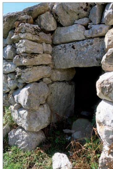
1. Vista posterior del *vellar*, construido en mampostería con toscos bloques de caliza colocados en seco. La falsa bóveda se recubre exteriormente con tapinos para garantizar su estanqueidad.
