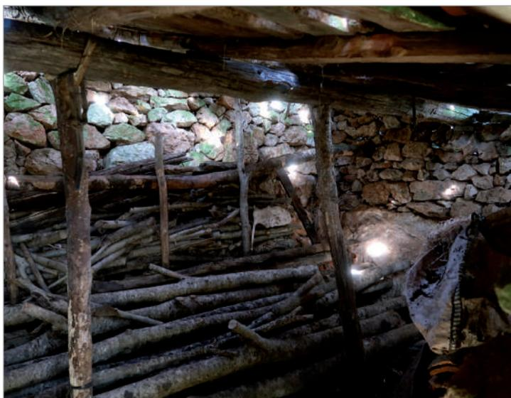
1-2. Dos vistas del *vellar*, con la puerta, único hueco de la construcción, orientada al sur. Es de destacar la mampostería, muy tosca, trabajada en seco.
