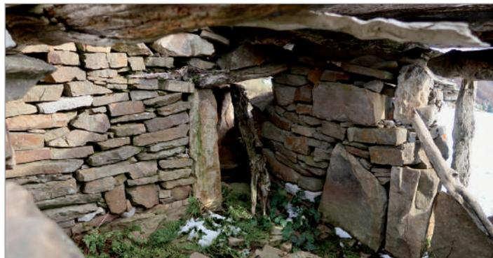
1. Una de las causas actuales de la destrucción de las cabañas: las vacas se meten en ellas para refugiarse del calor y se *tascan* (arrascan) contra las paredes haciendo que terminen por desplomarse las losas de la cubierta.
